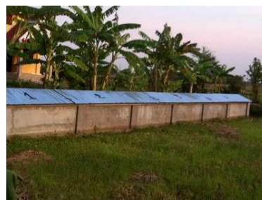
コンクリート製雨水タンク
